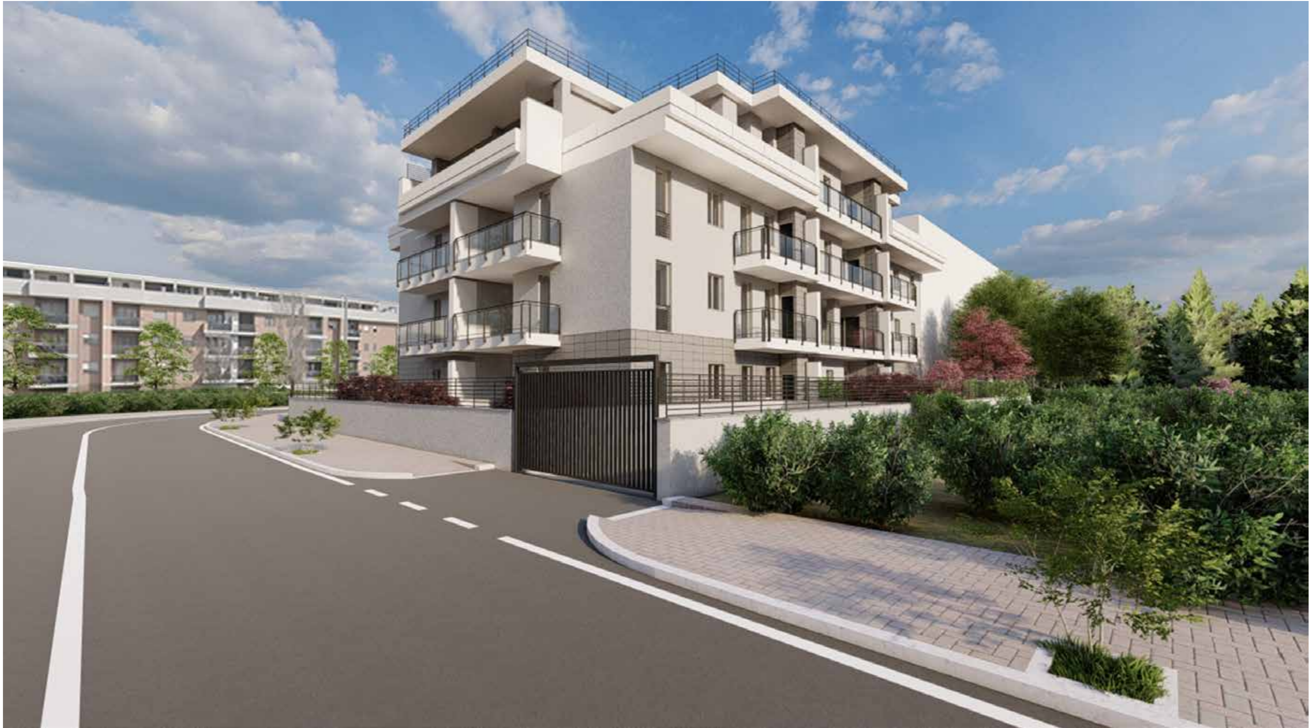
Edificio 7, vista ovest
